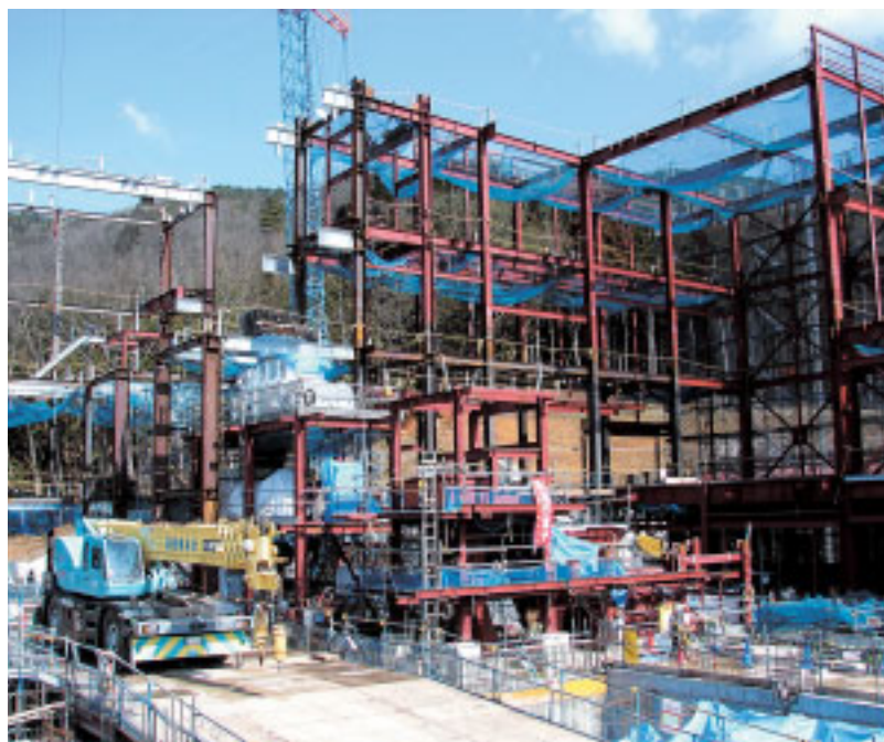
▲熱回収施設は鉄骨組立工事が着々と進んでいます。
