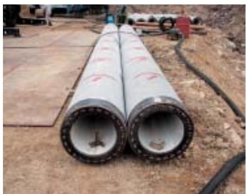
擁壁の底に基礎杭を施工します。使用する杭は、直径60cm、長さは5m～11mのコンクリート製で、約740本の杭を、杭打ち機と呼ばれる専用の機械で施工します。その後、鉄筋とコンクリートを使用した擁壁本体の工事を行います。
